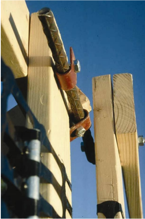
図 6.54. パネルは、図 6.11 に示された U-クリップを補強棒とともに使用することで接続される。左は、高さ 2.0m タイプの例 (Tabler1994)。
