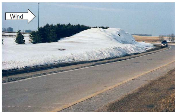
図 5.34. 防雪林の隙間と不十分な離れは道路上に深い吹きだまりの原因となる
