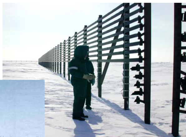
図 6.46. 垂直の振動が、ワイヤーレールセットを脱落させる。
