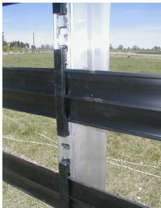
図 5.30. 巻き上げテンショナー（左）と ベルト受け付きのアルミニウム製支柱 （写真はパーマレイルインターナショナル の厚意により掲載）
