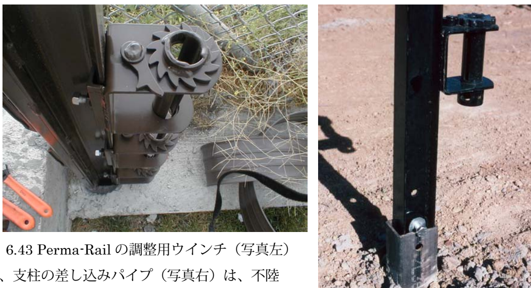
図 6.42. Perma-Rail 社の頑丈な支柱と取付金物が高い柵の建設を容易にさせる
