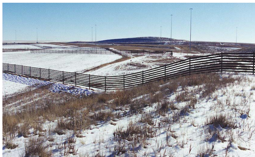
図 6.45. ワイヤーレールセットは、起伏のある場所でも適用できるが、低い箇所にある支柱は、ワイヤーレールによって発生する上向きの力を適切なアンカーで抑えなければならない。
