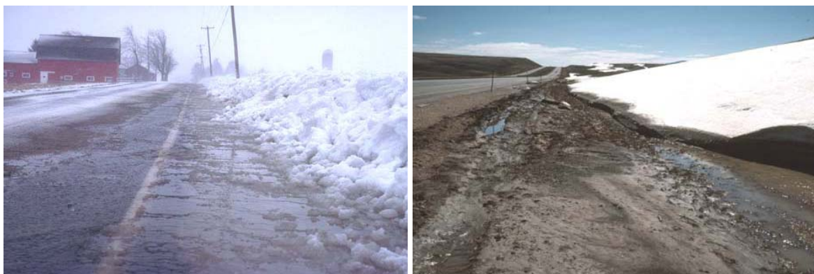
図 2.2 吹きだまりは排水を詰まらせ、舗装の下に水を浸透させることにより、道路を破壊する（左の写真は Tabler 1994 提供）。
