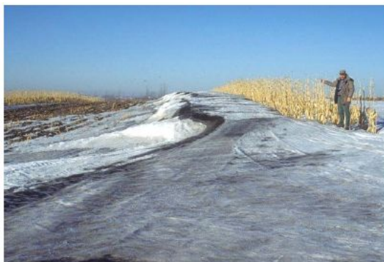
図 7.31 立ったままのトウモロコシが効果的で経済的な防雪柵となる (Tabler 1994)。
