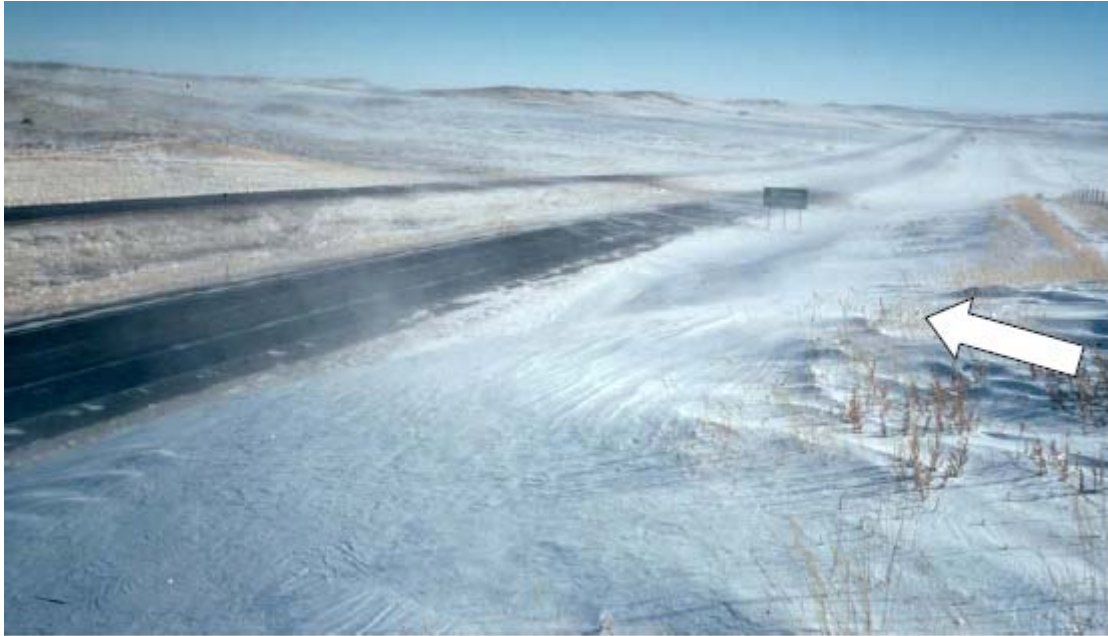
図 2.13 防雪柵で守られている領域の中心から撮影したこの写真は、視野の右外側に設置された高さ 3.8m 防雪柵風下で改善された視程距離を表している（矢印は風向である）。防雪柵の切れ目地点が、道路標識を丁度超えた、急激に道路状況が変わる地点と一致している(ワイオミング I-80、254 マイル地点、Tabler 1986 から引用)。
