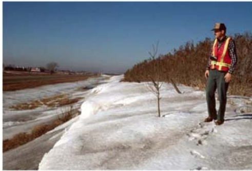
図 7.9 風上側の遠くに設置された高い防雪柵の代わりに、切土法肩に植えられた中低木を用いることができる。吹きだまりが道路に影響をおよぼさない場合を除いて、吹雪量を正確に決めなければならない。(スケッチは、Tabler より。 1994)
