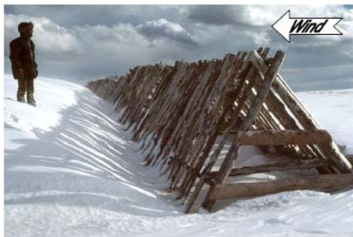
図 6.19 丸太防雪柵に取り付けられた垂直小割板
