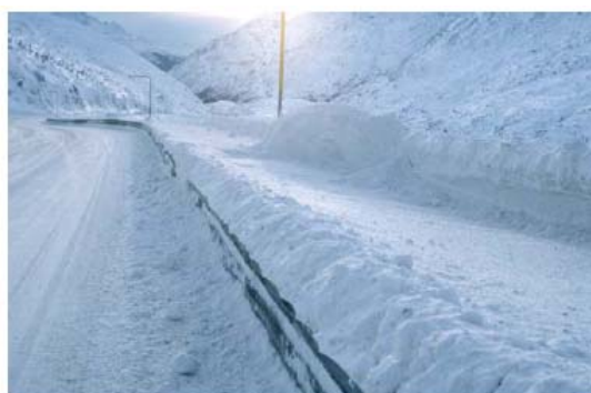
図 5.15 防護柵が路側雪堤の排除を妨げる。
