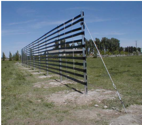
図 6.44. Perma-Rail のスリット穴付きアルミニウム製支柱と取付金物のセット 注意 金具は決められた箇所に使用する事。 写真は、Perma-Rail International 社の提供。
