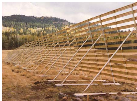
図 6.7. アリゾナ州運輸省によって設計されたアルミニウム製のワイオミング式の柵。
