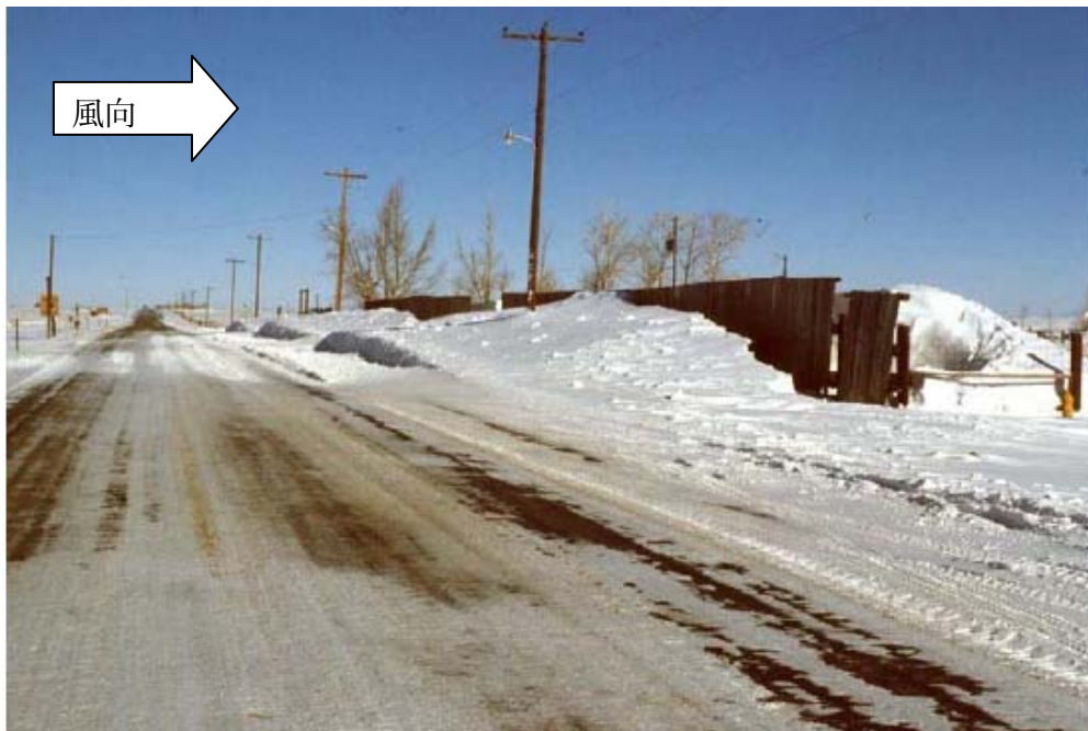
図4.4 2.4m(8フィート)の高い板塀が道路上に吹きだまりを生じている。主風向は写真の左側で、道路風下側の構造物や植生は非積雪期の現地踏査では見落とされやすい。
