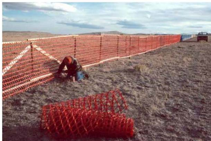
図 6.28 押し出し成形された高密度ポリエチレンによる防雪柵DuPont® Vexar®（現在の製品番号 L77）（Tabler, 1994）。
