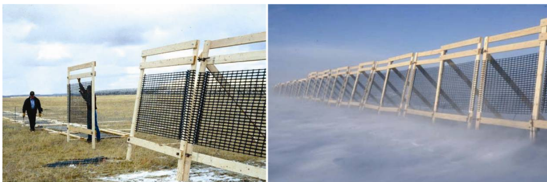
図 6.53. 高さ 2.0m 及び 2.4m の特許可動式防雪柵の設計には、Tensar® 社製柵材料を支持するための木製枠組を使用する (左、Tabler1994 より)。ここには高さ 2.4m タイプの例が示されている。
