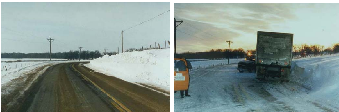
図 2.1 この致命的な事故は、カーブの吹きだまりによる見通し距離の低下が原因である可能性がある。
