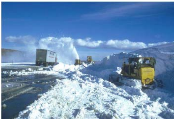
図 2.8 ワイオミング I-80、270.9 マイル地点の 1970 年の防雪柵設置前（上）と、設置後 31 年続いた典型的な積雪状況（右上）。右下の写真はこの地点の高さ 3.8m 防雪柵でできた深さ 6m の吹きだまりで、防雪柵延長 1m 当たりで 80 トンに相当する（Tabler 1973a から引用）。
