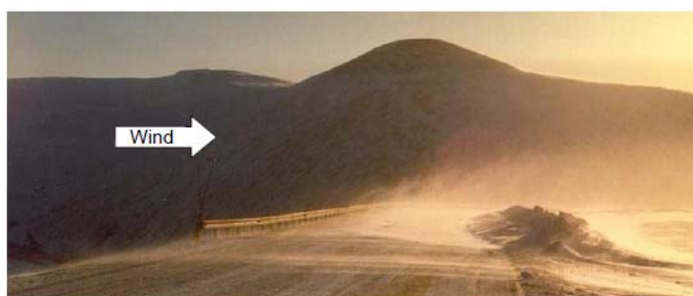
図 5.14 防護柵は著しい視程問題を引き起こし得る。写真提供 Craig Shelton, Alaska Department of Transportation and Public Facilities.
