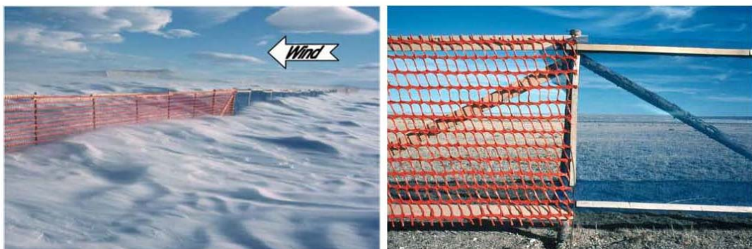
図 6.23 網の空隙率と防雪能力
