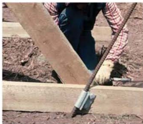
図 6.17. 滑動層の凍結と融解の対策として、永久凍土のアンカーの取り付けは、フェンスが垂直方向の移動を可能にしている。寸法はミリメートルである。
