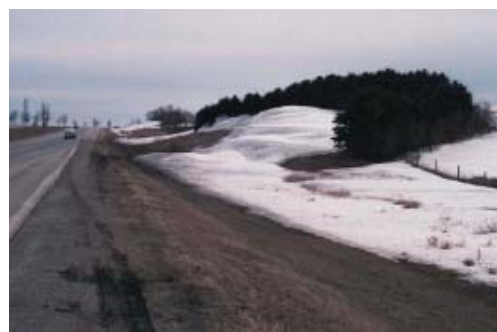
図 7.14 切土付近で囲うような植栽は、樹木の端部で道路上に大きな吹きだまりを形成させる。
