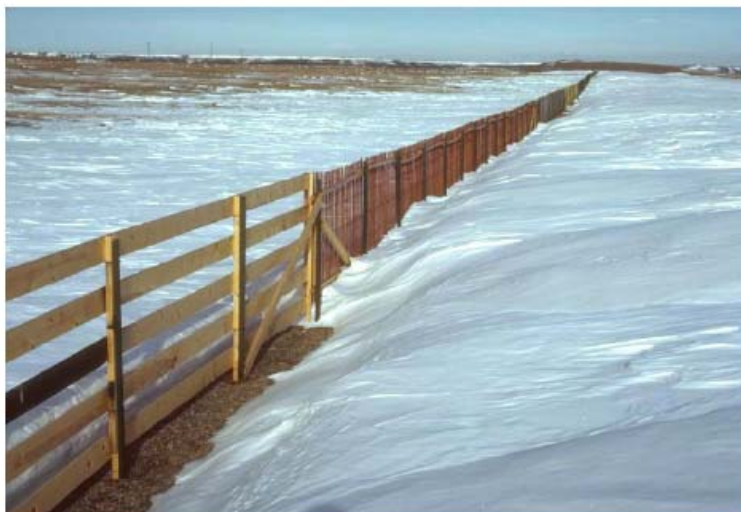
図 3.52 . 水平なスレートは雪が柵近くに堆積するのを遅らせる（Tabler 1986）。
