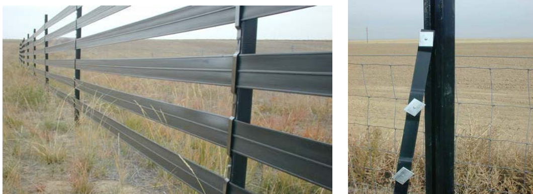
図 6.41. 調整可能な取付金物を取付けた C 型支柱
