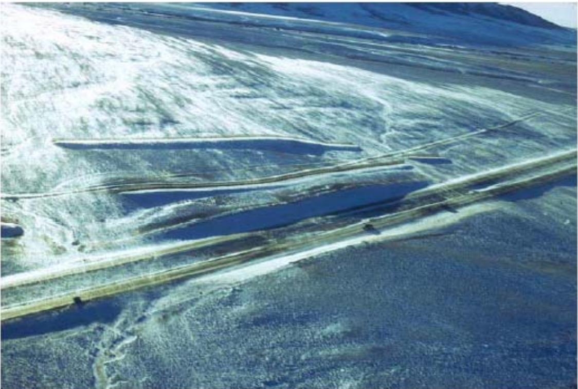
図 2.10 ワイオミング I-80、263 マイル地点で、ごくわずかな吹雪が 2 列になった 3.8m 防雪柵を回避しているのが見える（Tabler 1973a）。この写真撮影時点で、前にある防雪柵は満杯容量の 60%であった。写真は、Robert L.Jairell。
