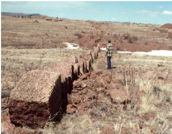
図 2.3 . ワイオミング南東部で鉄道を守っている、多分 1868 年に設置された岩でできた防雪柵（Tabler1986）。
