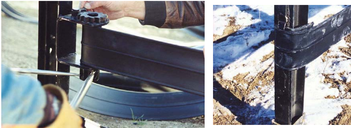
図 6.38 左：柵の設置と維持のために、柵の端に恒久的に取り付けられたラチェット・ストラップ・ウィンチ。右：支柱の末端処理の方法
