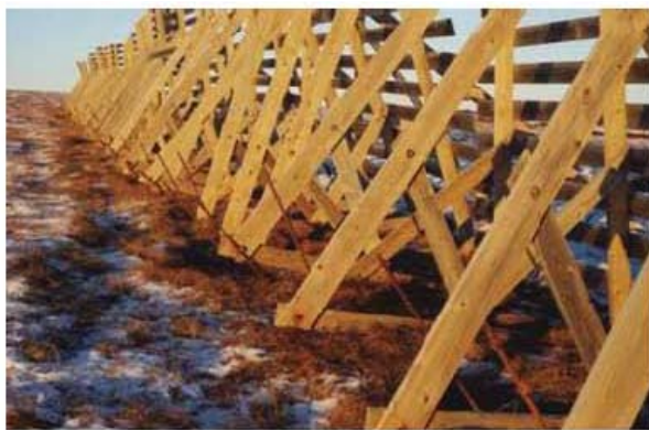
図 6.16.凍結融解の繰り返しによって、4.3m高のフェンスのアンカーが、土壌から押し出されている。（アラスカ ノーム付近）
