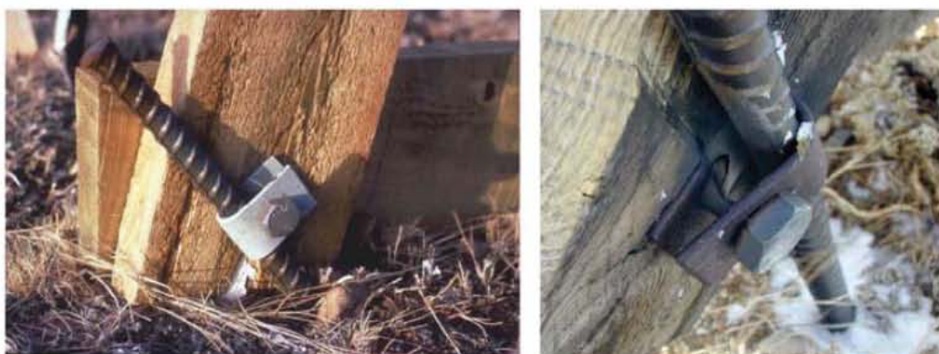
図 6.12. 滑りを防止するためU字-クリップをしっかりと締めなければならない。 右の図は、ボルトとU-字クリップで締めたアンカーであり、アンカーが擦れて金具が擦り減った状況を示している。
