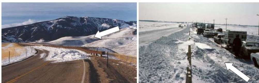
図 5.13 防護柵が吹きだまりの原因となる。左の写真は W-beam レール、右の写真はコンクリート製中央分離柵 (Tabler 1994)。矢印は風向を示す。
