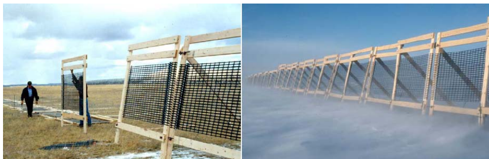
図 5.40. 2.0m と 2.4m の仮設柵の設計 (タブラー、1994 年)
