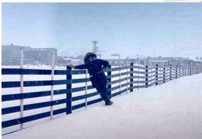
図 6.47. 強風の地域では、振れ留めは 1.5m 間隔を以内として用いるべきである。
