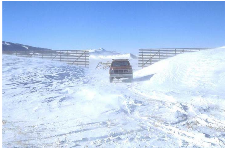
図 6.85. 通年での取付道路との接続に適した開口部(Type B, 図6.83)。柵高は4.3m。
