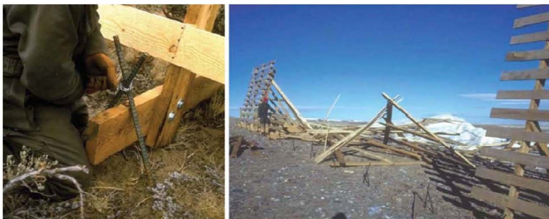
図 6.14. アンカーを交差させ、針金でとめる方法は、ワイオミングフェンスの取り付けに使用してはならない（タブラー1994）。
