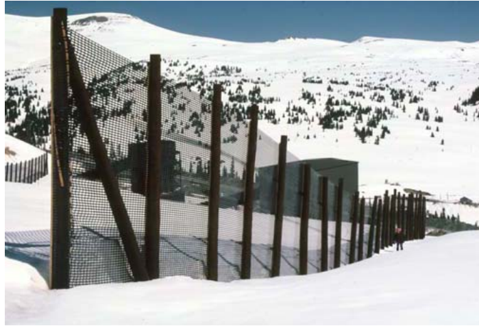
図 6.32. 端の支柱は、合成部材の引っ張りに対し、長手方向に筋交いで補強しなければならない。Tensar UX3100 が、コロラド州サミットヴィルにおいて、高さ 5m の防雪柵に用いられた。
