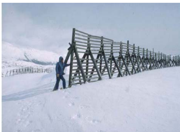
図 2.5. 1900 年に建設された高さ 4 m の、Alaska, Skagway の北およそ 25km に位置する、White pass と Yukon 鉄道の防雪柵。
