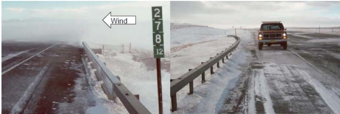
図 5.26 この視程の急変は WyomingI-80 で、高さ 3.8m ( 12.4ft ) の防雪柵の終端部で見られた。左側の写真は天候の急変時に、アンダーパスでもよく見られる現象である。右の写真は同時刻の反対側の方向で見られた、防雪柵に守られた範囲内の様子である ( Tabler1994 )。
