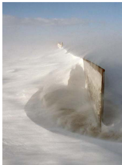
図3.60 高さ1.2mの空隙の無い柵の先端で噴射される雪粒子は風上の吹きだまりが空隙の無い柵先端に達した後なぜ捕捉率が低下する理由を示している。(Tabler 1994)
