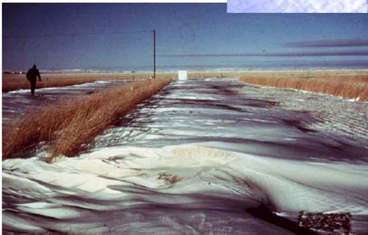
図 7.27 風に垂直な方向の草の列 を残すことは雪「の近く で」滞雪させる有効な方法 かもしれない。 写真提供ミネソタ運輸省。
