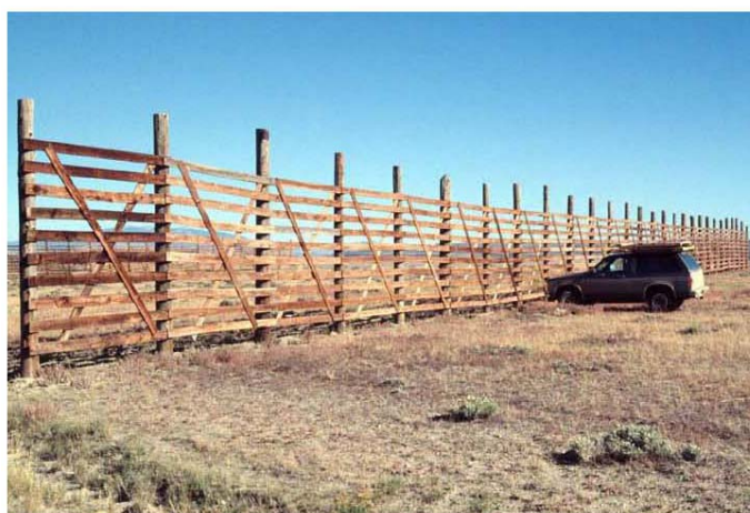
図-6.24 高さ3.3m の支柱で支持されたレール（Tabler.1994）。
