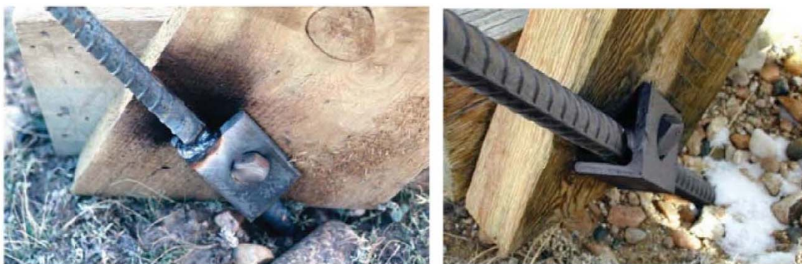
図 6.13. 三角金具は、アンカーの取り付け材として使用できるがアンカーと溶接して固定させなければならない。溶接しない場合は、木材の乾燥と収縮によって取り付けに緩みが生じてしまう。右の写真は、振動によって仮付け溶接が破断した例を示している。左の写真は、タブラー（1994）からである。
