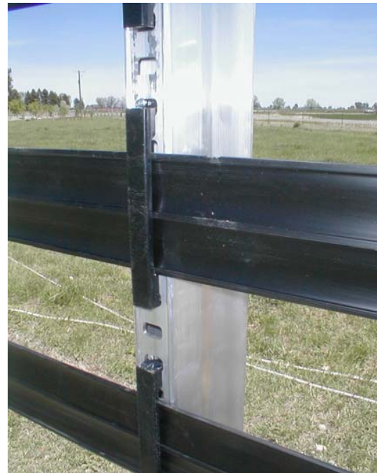
図 6.44. Perma-Rail のスリット穴付きアルミニウム製支柱と取付金物のセット 注意 金具は決められた箇所に使用する事。 写真は、Perma-Rail International 社の提供。
