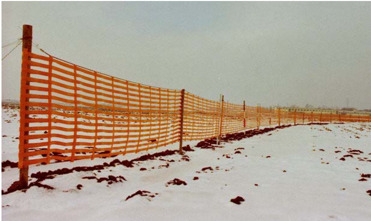
図 6.50. 支柱間のワイヤーで支えら れた PARAWEB 柵 Liner Composites 社の提供。
