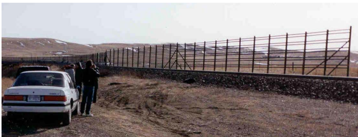
図 6.37 柵の最後の 90m 区間において、減風度合いを段階的に減らすことで、柵の防風域末端での風速の急変を防ぐために、複合ポリマーワイヤーレールが使われた。
