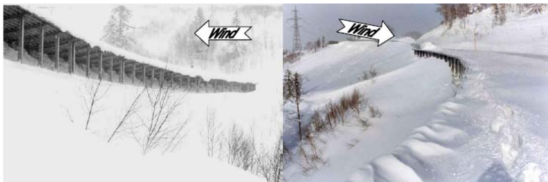
図 6.3 日本の北海道の中山峠近傍の吹き上げ防止柵、道路の下に斜面に雪を溜め、雪を垂直に拡散させ、道路上への堆雪を遅らせる(Tabler 1994)。右の写真は北海道開発局の打矢徹也氏の提供。
