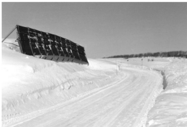
図 6.63. 吹き払い柵による切土の積雪減少効果（北海道開発局、打矢徹也氏 撮影）
