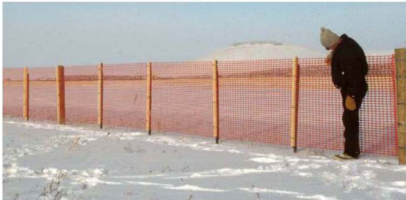
図 6.29 穴あけ成形した高密度ポリエチレンによるConwed Plastics 社製「万能フェンス」 (Tabler, 1994)
