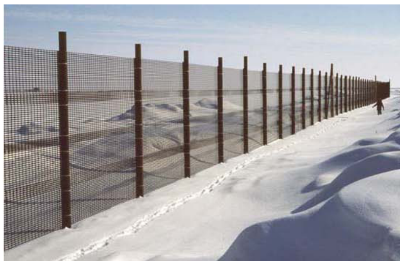
図 6.30 Prudhoe Bay , Alaska に設置された高さ 4.6m ( 15 ft ) の防雪柵 Tensar Corporation 社製 の UX3100 の高密度ポリエ チレンを使用した防雪柵 (Tabler, 1994)
