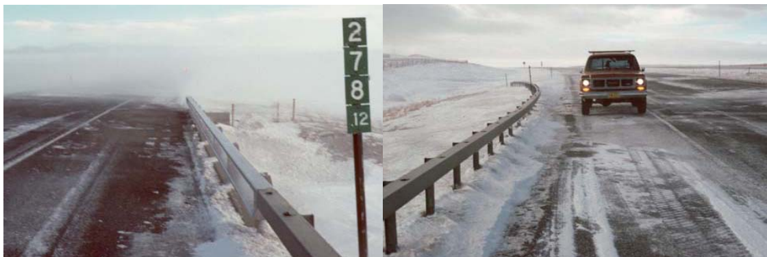
図6.86. 防雪柵の端部における視程の変化（柵高3.8m、ワイオミングI-80道路）。左の写真は、作業機械用アンダーパスの向こう側にある、柵の端部の急激な変化を示している。
