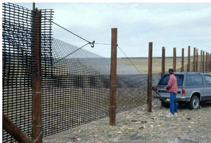
図 6.35. 重なったプラスチックの柵部材をピンと張る方法 .
