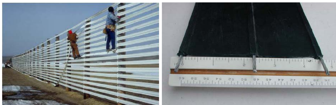
図 5.29. 柵の素材である合成ポリエチレンと金属製の燃ったケーブル（ケンタウルス HTP）
