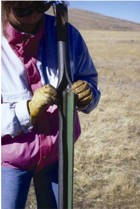
図6.52 鉄製T型支柱にかぶせられた発泡断熱パイプは、ラス（木摺）よりも良く柵を固定する (Tabler1994)。
