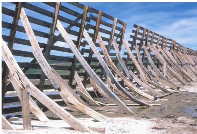
図 6.9. 雪圧による被害を受けた従来設計である高さ 3.6m の柵。被害を防ぐためには、方杖が重要であることを示している。
