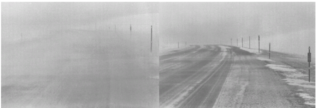
図 2.12 穏やかな吹雪の間の、3.8m 防雪柵風下で改善された視程距離。写真右側は防雪柵で守られた領域から 60m 離れた所で撮影された。右側の写真は、数分後に防雪柵で守られている領域の境界点に立ち撮影された。写真はワイオミング運輸局の Keith Rounds による（Tabler 1973a から引用）。
