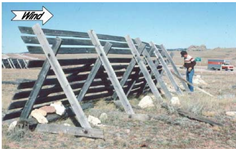
図 6.20 スウェーデン（あるいはノールウェー）型防雪柵。この高さ 2 m の防雪柵は写真撮影時設置から 45 年経っていた (Tabler1986b)。
