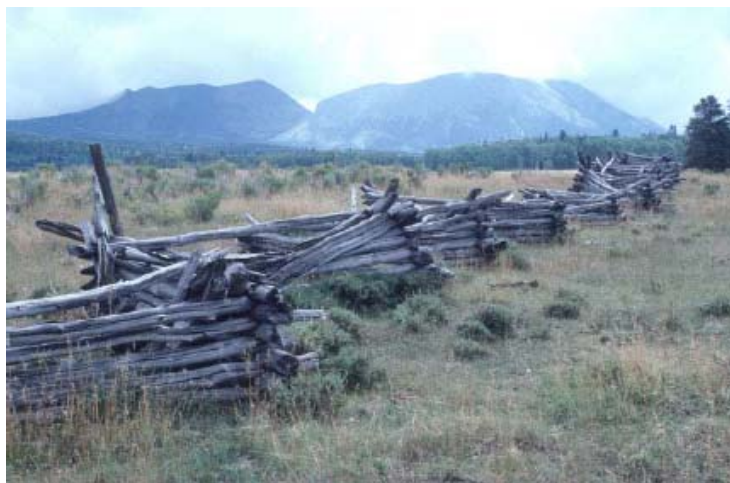
図 6.21 コロラド州，La Veta Pass 近くの棒積み防雪柵 (Tabler 1986b)
