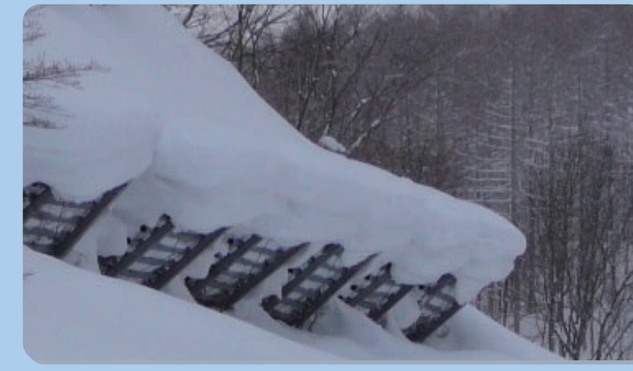
▲巻きだれの発達事例 Snow eaves on avalanche fences
