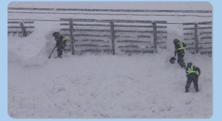
▲雪処理作業の状況 Snow removal on a slope
