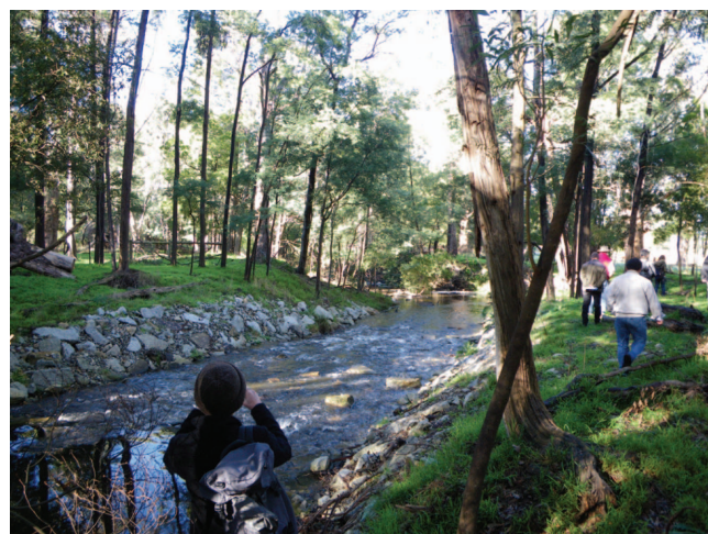
写真-5 Upper Bunyip川の上流における自然石護岸
