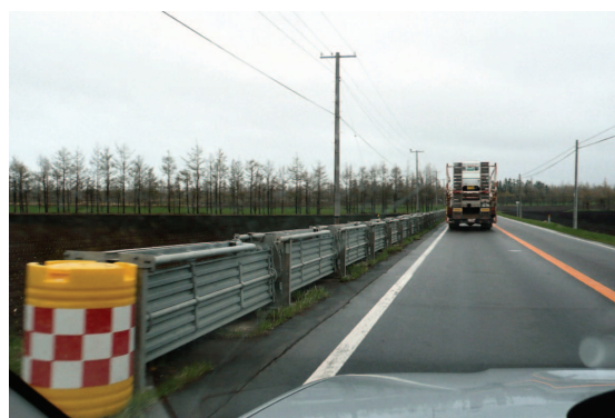
写真-19 収納状態で路面より高い防雪柵、景観向上のための施設の端部には緩衝施設が設置され、景観阻害と付属施設の連鎖を招いている
