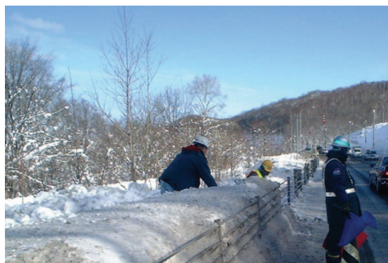
写真－6 防護柵背面の人力除雪
