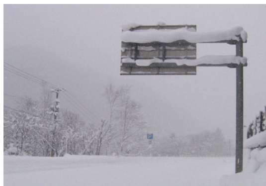
写真－5 片持式標識への着雪状況事例
