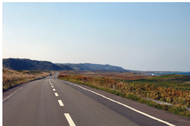
写真-20 完全収納型の防雪柵設置区間の状況 良好な景観が保たれている
