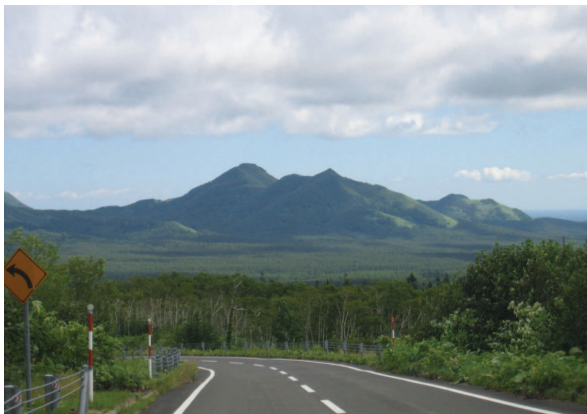
写真-22 景観への影響が小さい伸縮式スノーポール 収納するとさらに改善される
