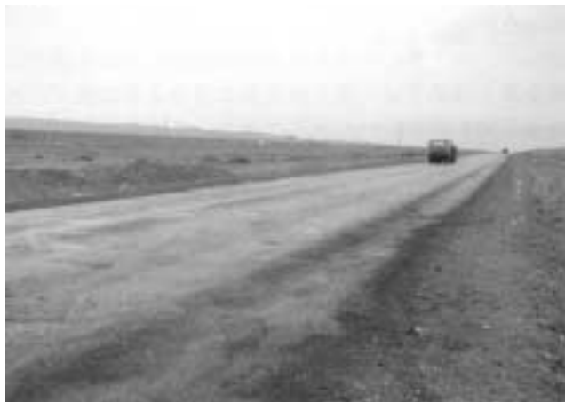
写真 15 国道 312 号線を走るトレーラー
