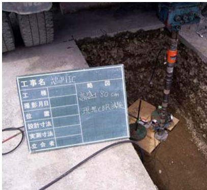
写真-4 現場 CBR 測定状況
