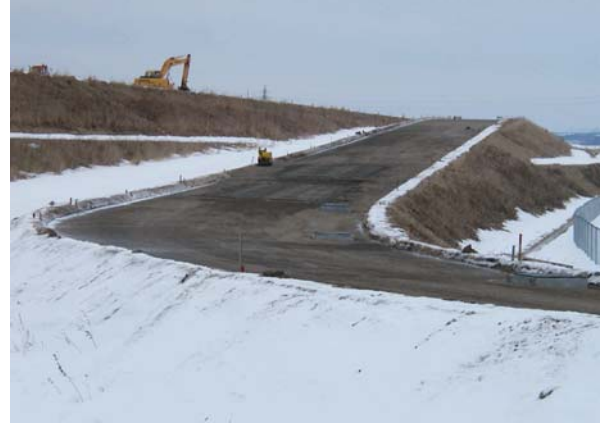
写真-2 鷓川 IC 試験ヤード
