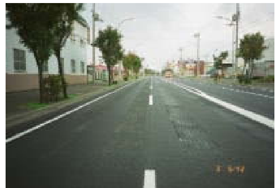
写真－2 開粒度充填舗装設置状況 （上：充填割合100%、下：充填割合50%）
