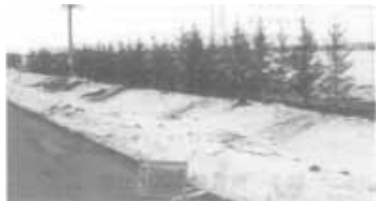
写真1 間伐材による狭帯防雪林の設置状況
