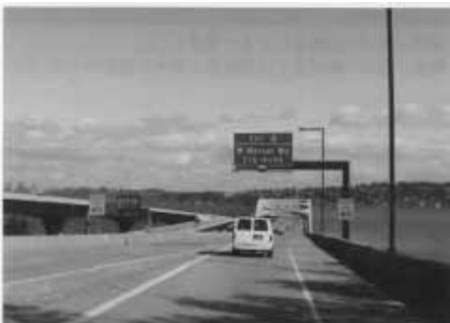
写真-14 トンネルを抜けると Lake Washington が車窓に広がる
