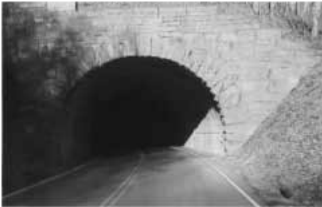
写真 - 8 天然石を施したトンネルの坑門
