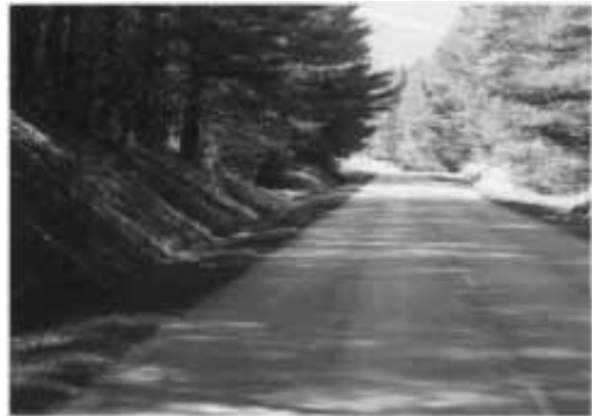
写真 - 4 路肩芝生の管理状況
