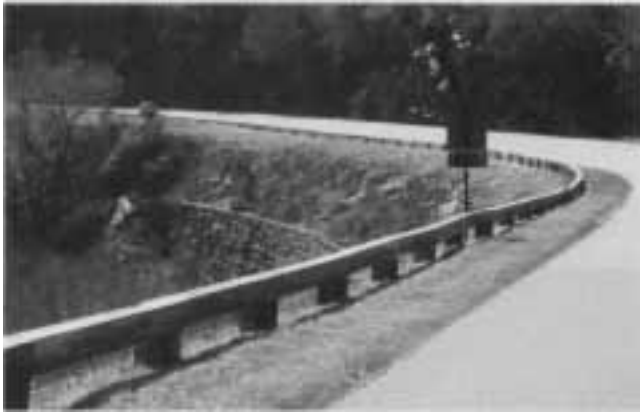
写真 - 7 天然石を使用した法留め擁壁と木製の車止
