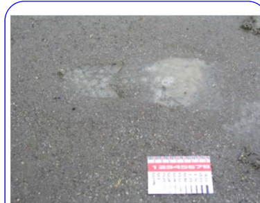
除雪車の重みによって壊れた箇所
