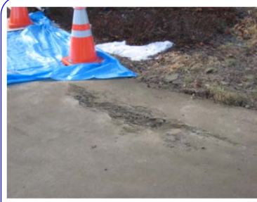
除雪車の重みによって壊れた箇所
