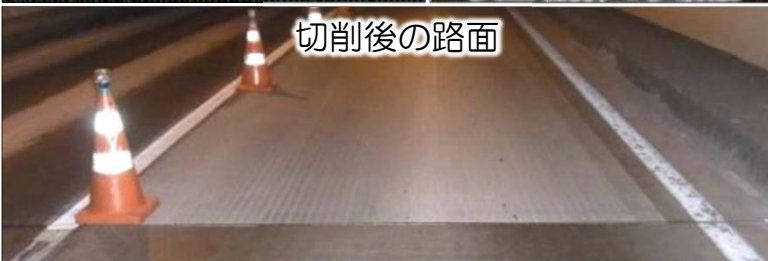
骨材が露出する
