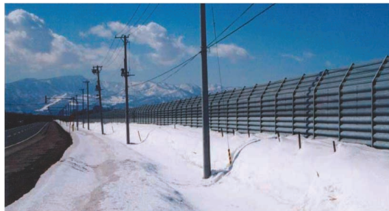
吹き止め柵(一般国道337号石狩市)
