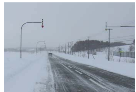
写真4-3-5 固定式視線誘導柱（矢羽根）
