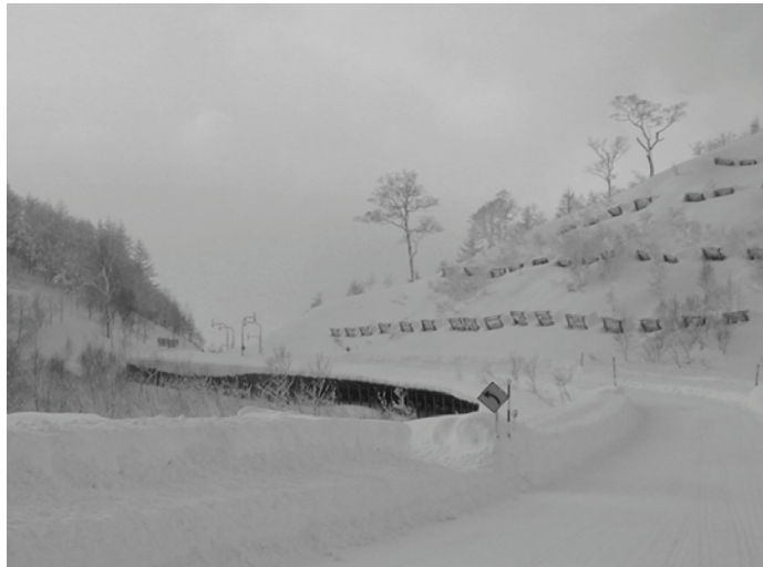
写真3-2-3 吹き上げ防止柵
