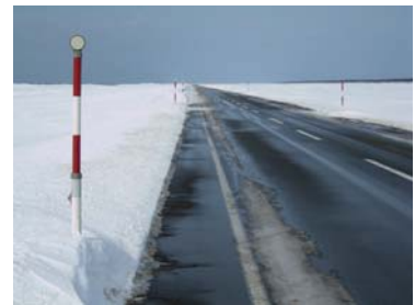
写真4-3-2 伸縮式の視線誘導標
