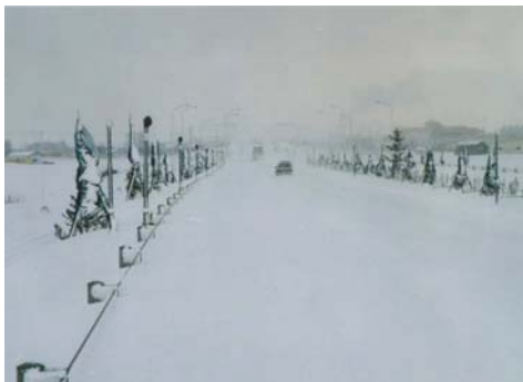
写真4-3-6 視線誘導樹（一般国道337号石狩市）
